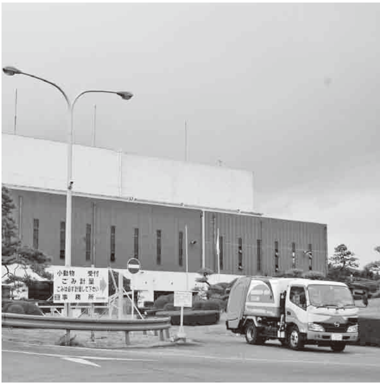
▲ 老朽化が進んでいるごみ焼却施設（環境事業センター）
