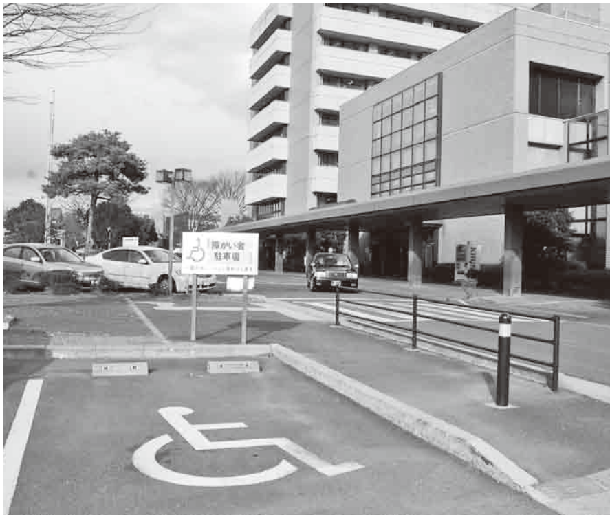
▲ 入口まで屋根がない障がい者用駐車場
